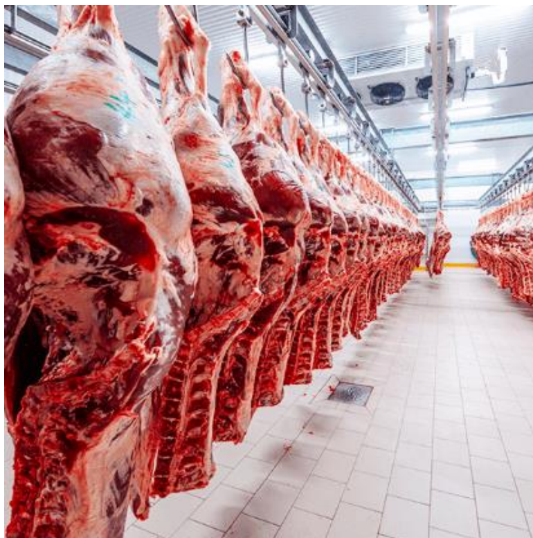
Figura 9- Carcaças em câmara fria frigorífica.
