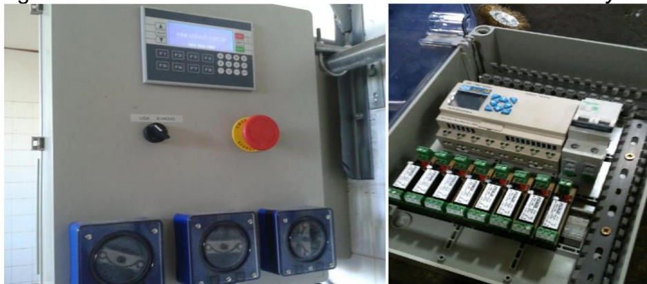
Figura 2.8 - Sistemas IHM e CLP utilizados na ordenha side by side
